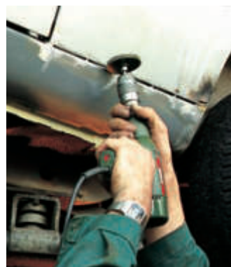
Schweißnahtbearbeitung mit einer Delta Schaftgrundbürste.
